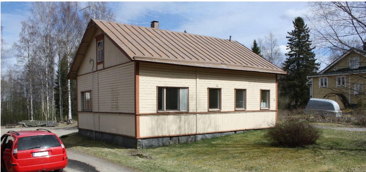
Kuva 6. Näkymä Linnantieltä, Osulan rakennus
