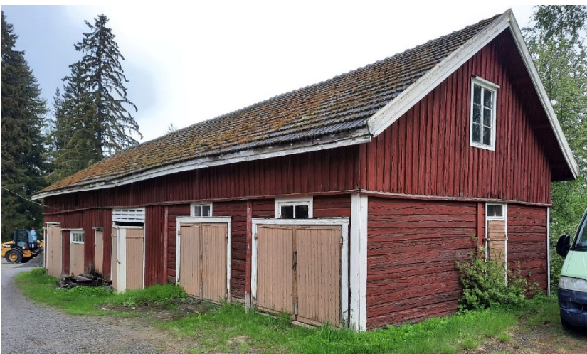
Kuva 7. Kunnantalon pihalla oleva varistorakennus
